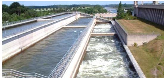
Bei der Schleuse Uelzen II sind es vier beidseitig übereinander liegende Sparbecken, die insgesamt 70 % der Schleusenkammer füllen. Die Verlustwassermenge beträgt nur noch 30 %. Sie ist damit die derzeit größte Sparschleuse der Welt.
