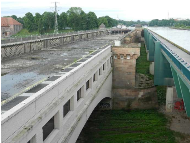
Foto: Trockenlegung der alten Kanalbrücke im Jahr 2014
